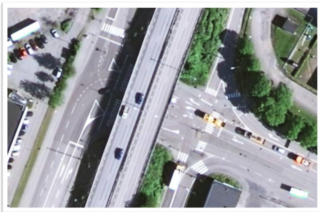
Slakthusmotet idag med av- och påfarter vid Slakthusgatan för norrgående körriktning
